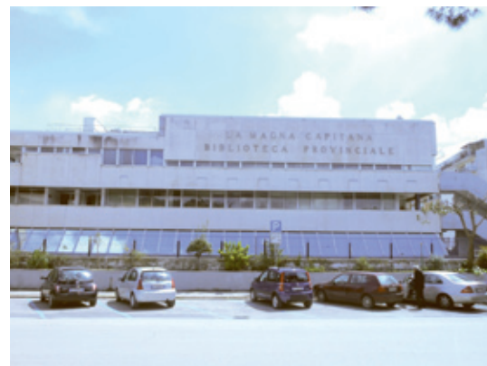
La Biblioteca provinciale di Foggia
